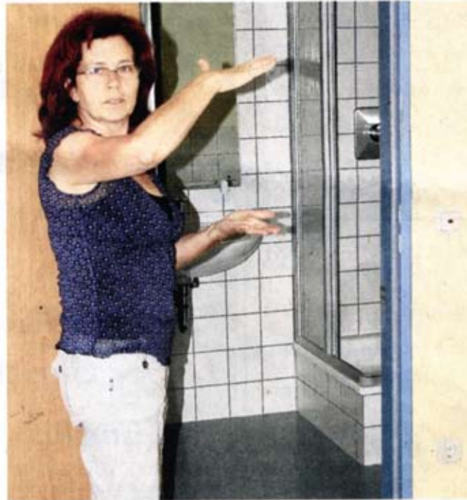
Für Rollstuhl und Rollator müssen in den Zimmern Türen verbreitert und andere kleine Umbauten getätigt werden.
