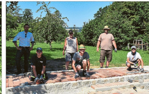
Ausbilder Axel Meyle baut mit den Auszubildenden eine Plattform für die Bogenschützen.
