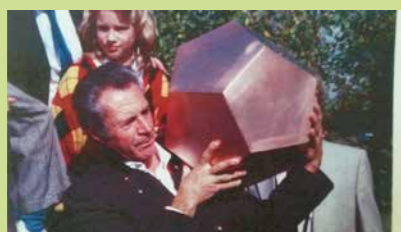
Ludwig Bartl mit Grundsteinbulle des Schulzentrums
