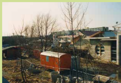
Bauwagen vor Schwimmhallenrohbau
