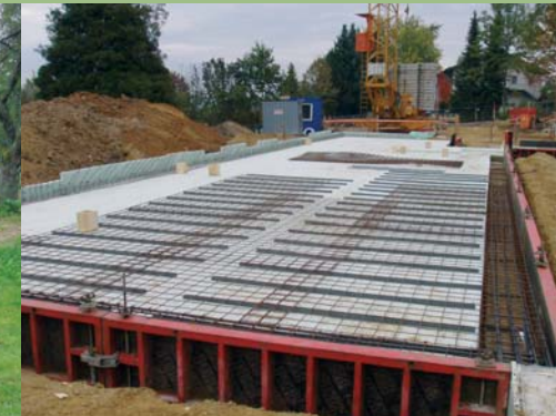
22.10.05 Die Fundamente sind gelegt
