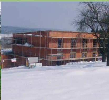
18.03.06 Der Rohbau steht
