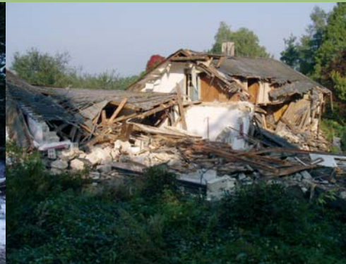
24.09.05 Der Abriss beginnt
