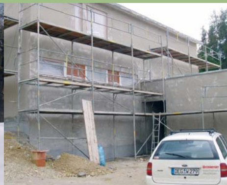
31.05.06 Das Wohnheim wird verputzt
