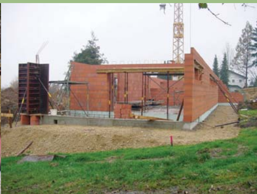
05.11.05 Das Erdgeschoss steht
